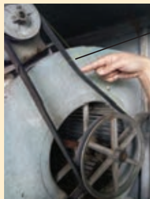
آزمایش سفتی تسمه
