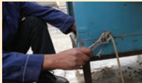
نصب لوله به شیر شناور
