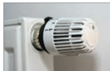
رادیاتور با شیر ترموستاتیکی
