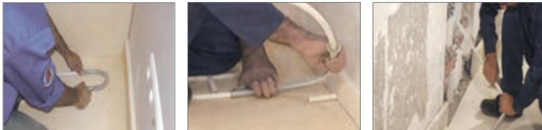
استفاده از فنر برای خم کردن لوله
