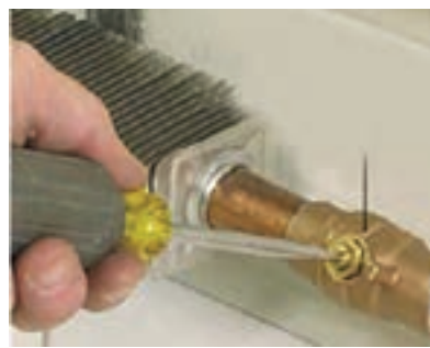
شیر هواگیری کنوکتور
