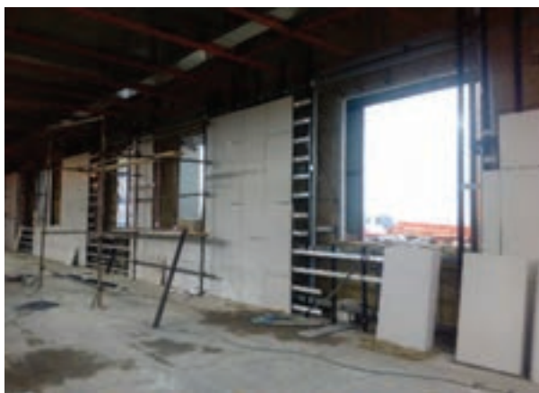
اجرای زیرسازی فلزی
