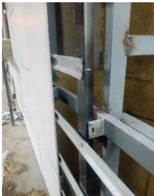
نمایی از اتصال قطعه به زیرسازی
