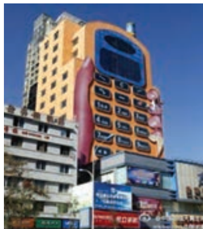
شکل ۱۱۰-۳- تصویر چاپ بر روی ساختمان
