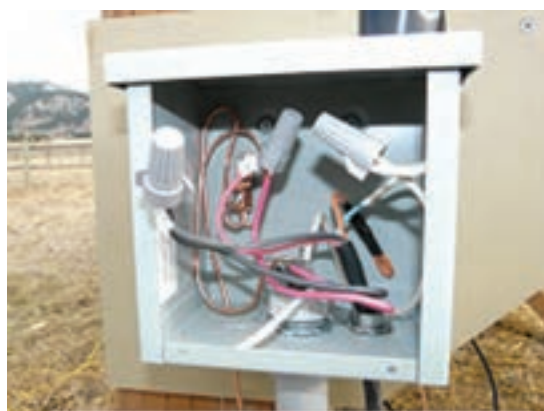
شکل ۳۵- اتصال میله مسی به بدنه تابلو اتصالات
