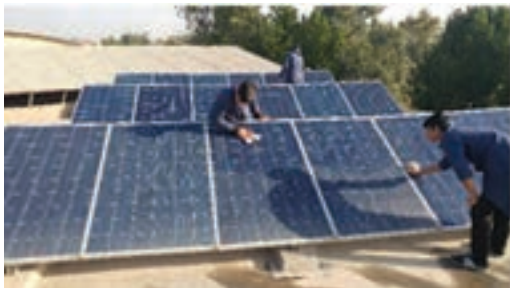
شکل ۴- تمیز کردن مدول‌های خورشیدی
