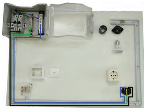
شکل ۵-۱۰- انجام سیم‌کشی پریز ۱
