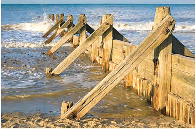
نصب حفاظ عمودی
