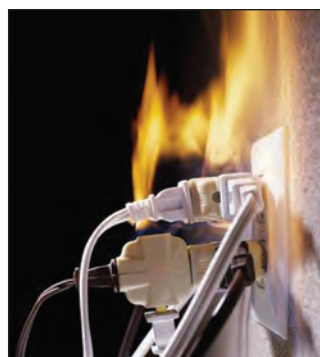
▲ شکل ۲-۱- آتش‌سوزی حاصل از ایجاد جرقه و سوختن سیم‌های برق
