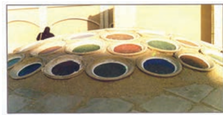
شکل ۲-۱۲- استفاده از گلجام در بازسازی سقف حمام
