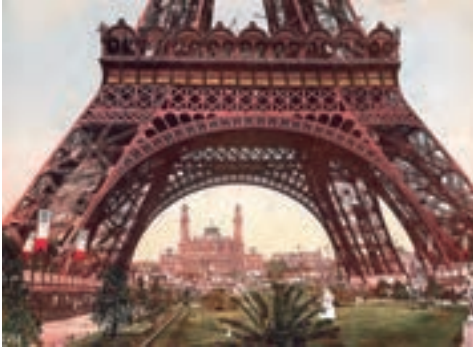
شکل ۲-۱۰- برج ایفل در حال ساخت - پاریس ۱۸۸۹ میلادی
