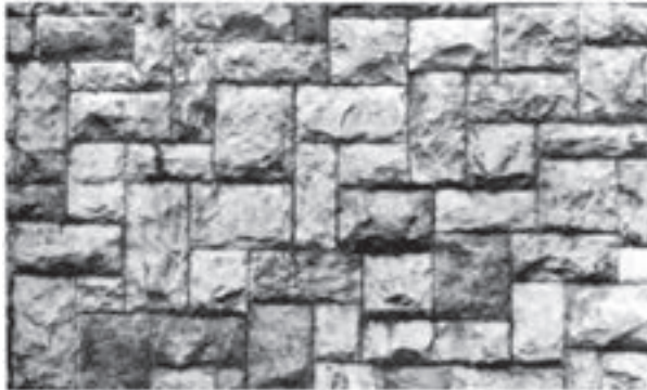
شکل ۹-۴- استفاده از سنگ بادر در نما
