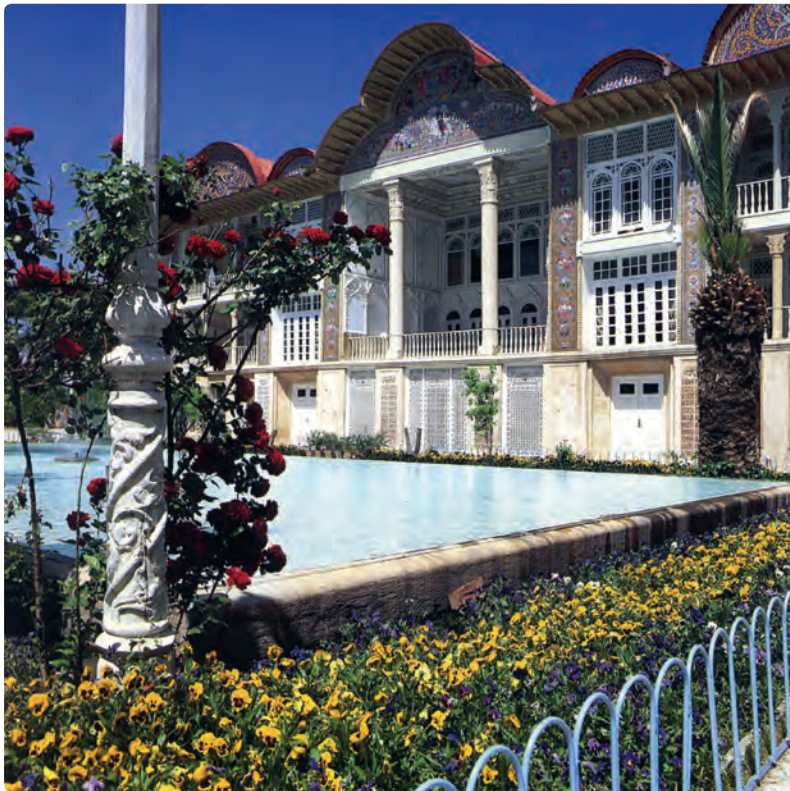
تصویر ۴۲- یک ساختمان برونگرای قاجاری
