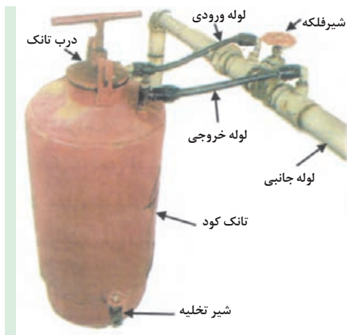
شکل ۴۹-۵. اجزای سیستم توزیع کود
