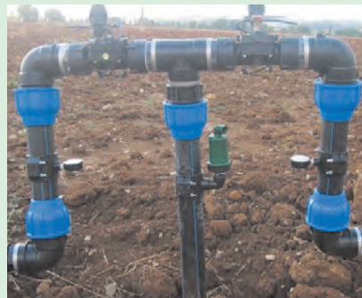
شکل ۳۲-۵. شیر و فشار سنج روی بال ها
