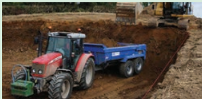
شکل ۲۱-۴- بارگیری نامناسب پی نورد
