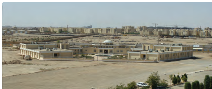
شکل ۲۰-۶- احداث درمانگاه تخصصی و فوق تخصصی بیمارستان شهید صدوقی
