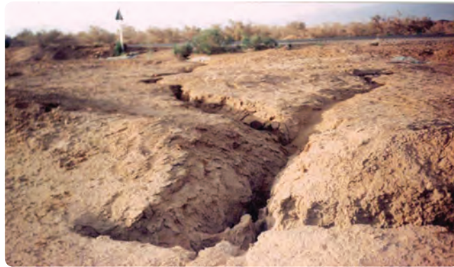
شکل ۱-۵۴- پدیده فرونشست در منطقه رضوان شهر
