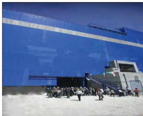
شکل ۱۸-۵- مجتمع فولاد ویان - کبودرآهنگ
