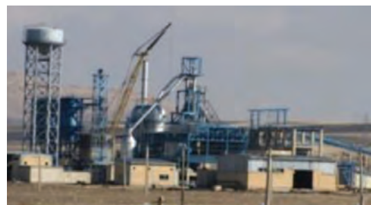
شکل ۴-۶- مجتمع ذوب آهن - اسدآباد
