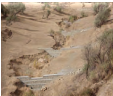
شکل ۱-۶۳- بند گابیونی (سنگ ها در تور سیمی)
