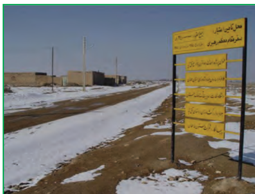
شکل ۶-۶- پروژه احداث راه روستایی - آق تپه
