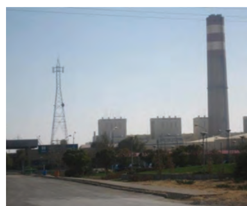
شکل ۱۹-۵- نیروگاه برق شهید مفتاح - فامنین
