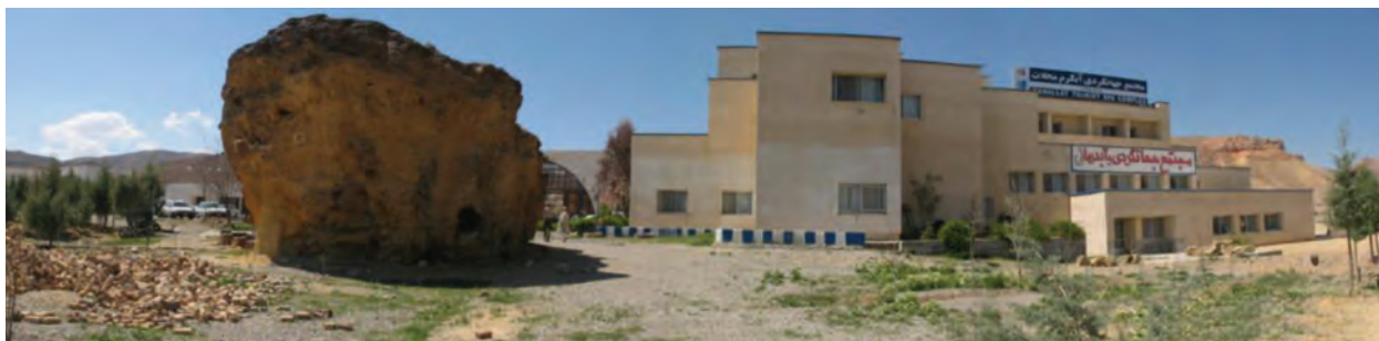
شکل ۵-۵- مجتمع آبگرم محلات
