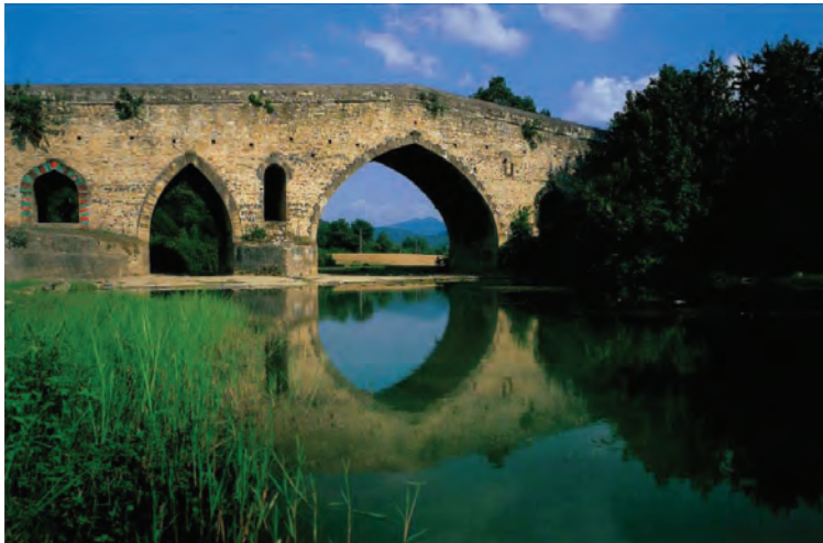
شکل ۲-۵- پل شاهپور در شیرگاه
