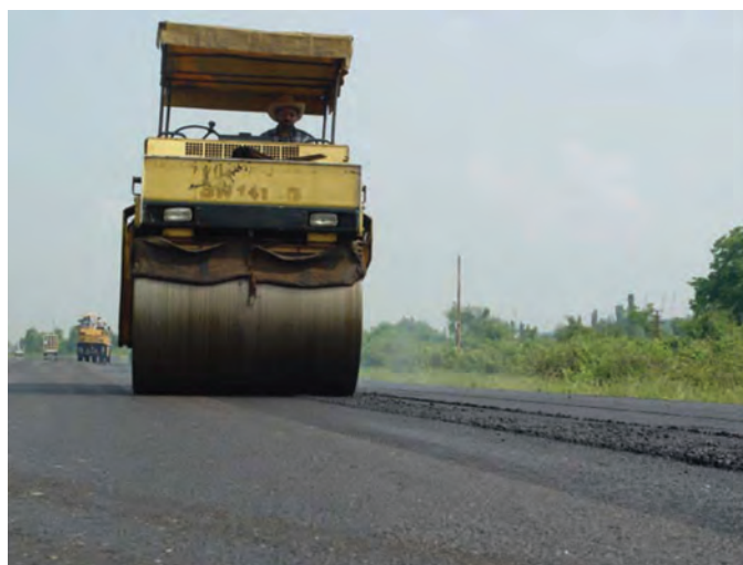
شکل ۴-۶- عملیات راه سازی
