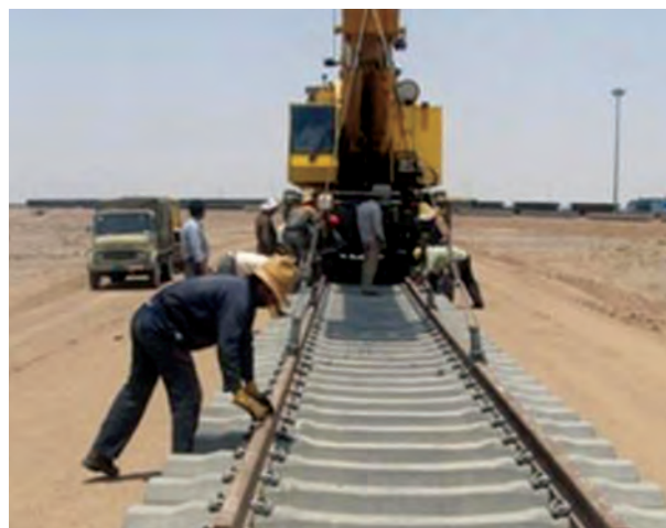
شکل ۱۵-۶- مراحل ساخت راه آهن قزوین - رشت - آستارا
