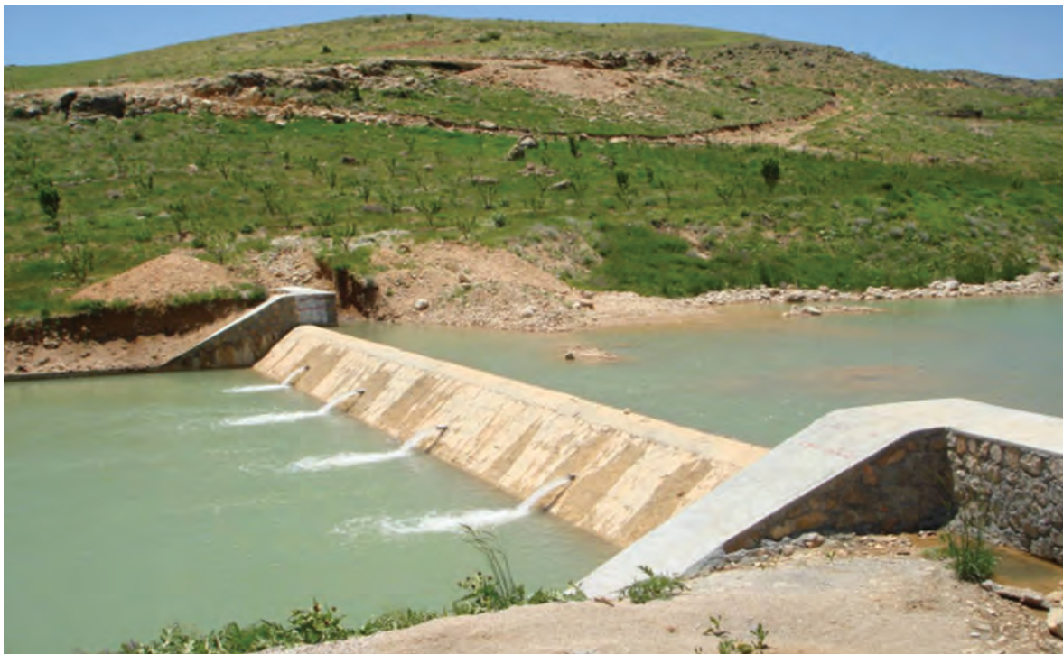
شکل ۲۶-۱- پروژه آبخیزداری بندسنگی ملاتی سرچنار
