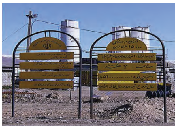
شکل ۱۰-۶- ورزشگاه ۱۵۰۰۰ نفری قزوین در حال ساخت
