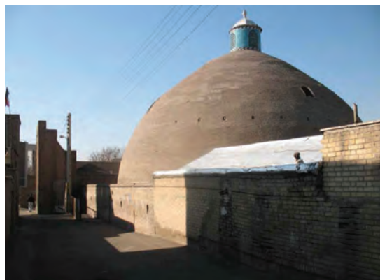
شکل ۱۰-۵- آب انبار سردار قزوین
