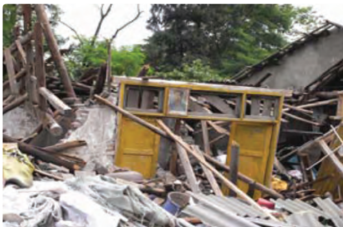
شکل ۱۱-۱- عدم رعایت شرایط مناسب خانه‌سازی، عامل اصلی خسارات ناشی از زمین‌لرزه است.
