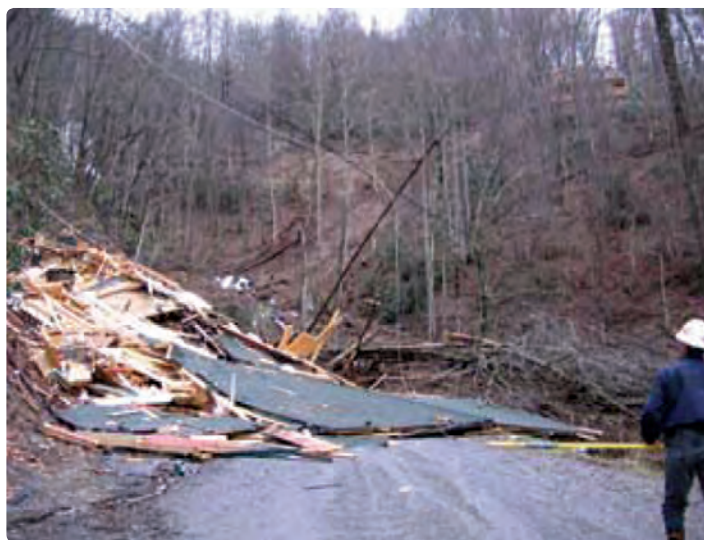
شکل ۱۲-۱- تخریب ناشی از رانش زمین
