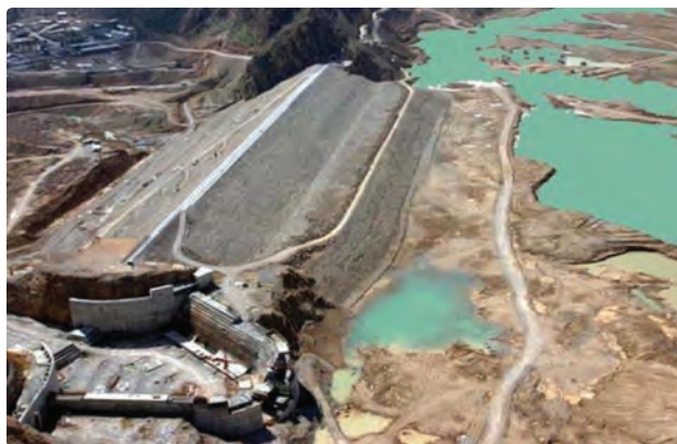
شکل ۱-۲۵- احداث سد سیوند بر روی رود سیوند
