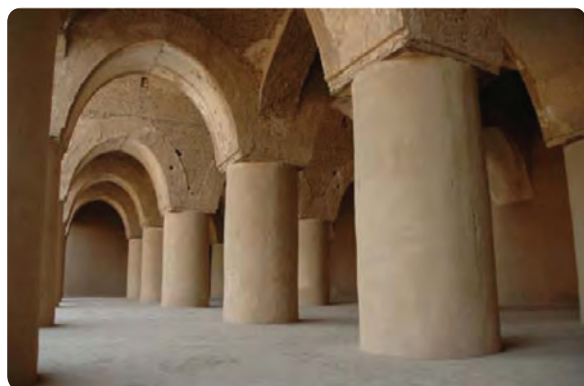
شکل ۱۴-۵- مسجد تاریخانه در شهر دامغان
