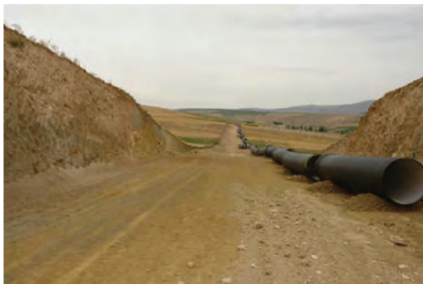
شکل ۱۳-۶- اجرای پروژه انتقال آب از سد شیرین دره به شهر بجنورد
