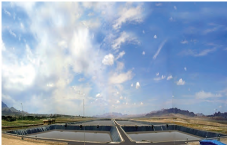
شکل ۱۶-۵- تصفیه خانه فاضلاب شهر بیرجند
