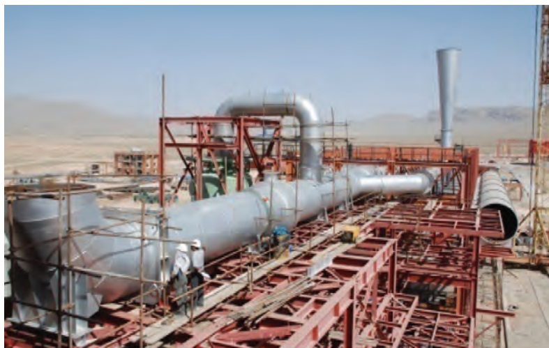
تصویر ۱-۱۵- کارخانه درحال احداث فولاد چهارمحال
