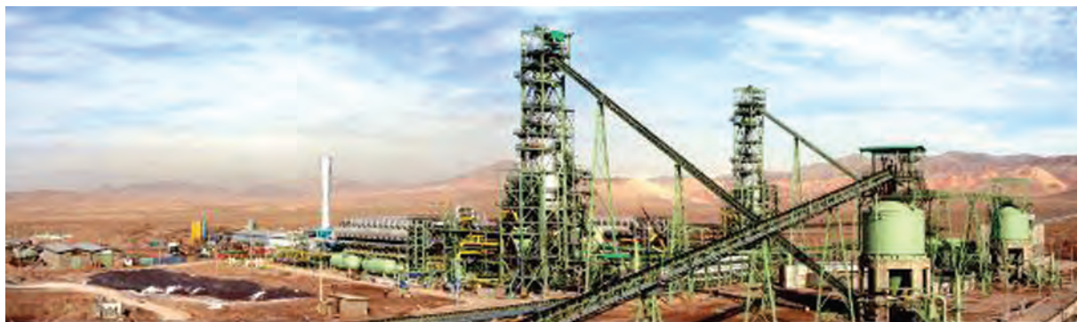
شکل ۳-۶- نمای از کارخانه فولاد خراسان - نیشابور
