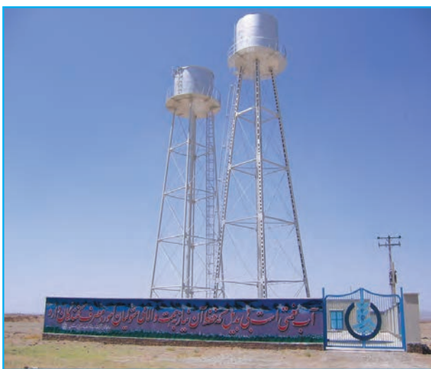
شکل ۱۰-۱۴- اجرای طرح آبرسانی بهداشتی روستایی
