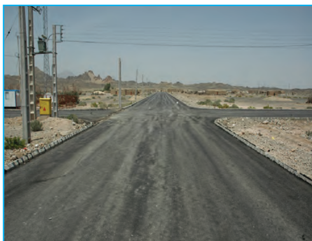
شکل ۹-۱۴- اجرای طرح‌های روستای چگرد خاش
