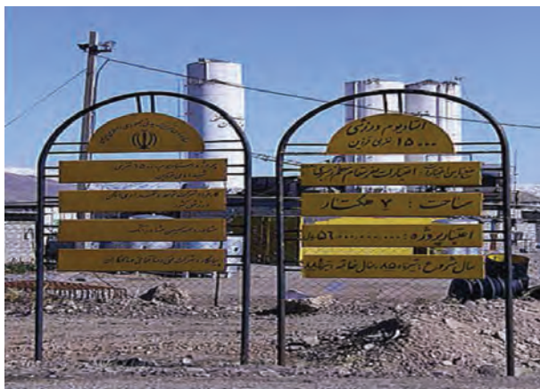
شکل ۱۰-۶- ورزشگاه ۱۵۰۰۰ نفری قزوین در حال ساخت
