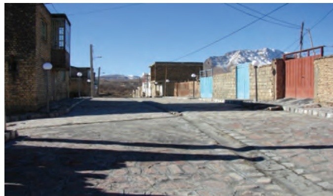
تصویر ۱۴-۱- اجرای طرح‌های روستایی
