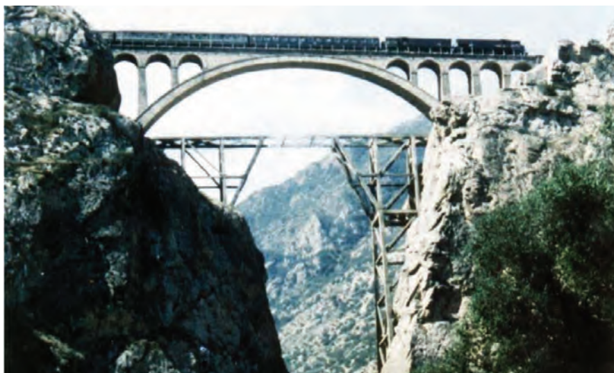
شکل ۲۸-۵- راه آهن شمال - پل ورسک
