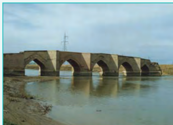
شکل ۲۶-۵- پل میرزا رسول در میاندوآب
