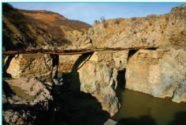
شکل ۲۷-۵- پل قالاتاسیان سردشت
