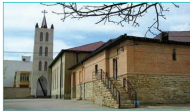
شکل ۳۹- کلیسای ننه مریم - ارومیه
