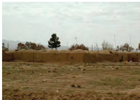
شکل ۲۰-۲- خانه‌های روستاهای نیمه بیابانی (امیرآباد چاچرم)
