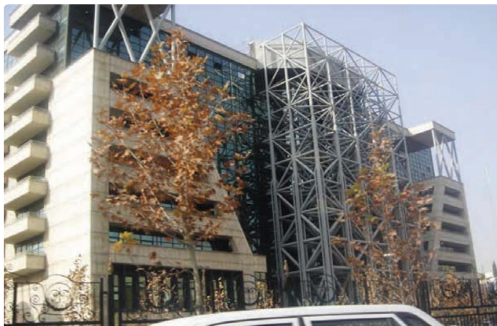
شکل ۱۲-۲- ساخت و سازهای جدید شهری
