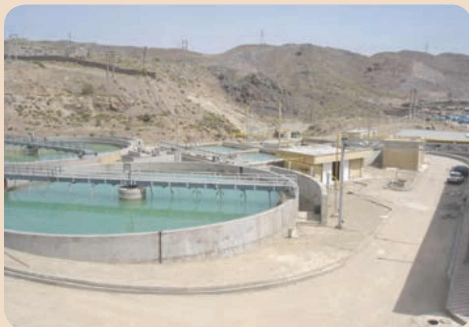
شکل ۱-۶۰- تصفیه خانه مجتمع مس سرچشمه
