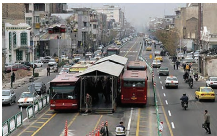
شکل ۲۹-۱- ایستگاه اتوبوس‌های تندرو (BRT)
