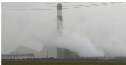
شکل ۴۸-۱- آلاینده‌های نیروگاه حرارتی
