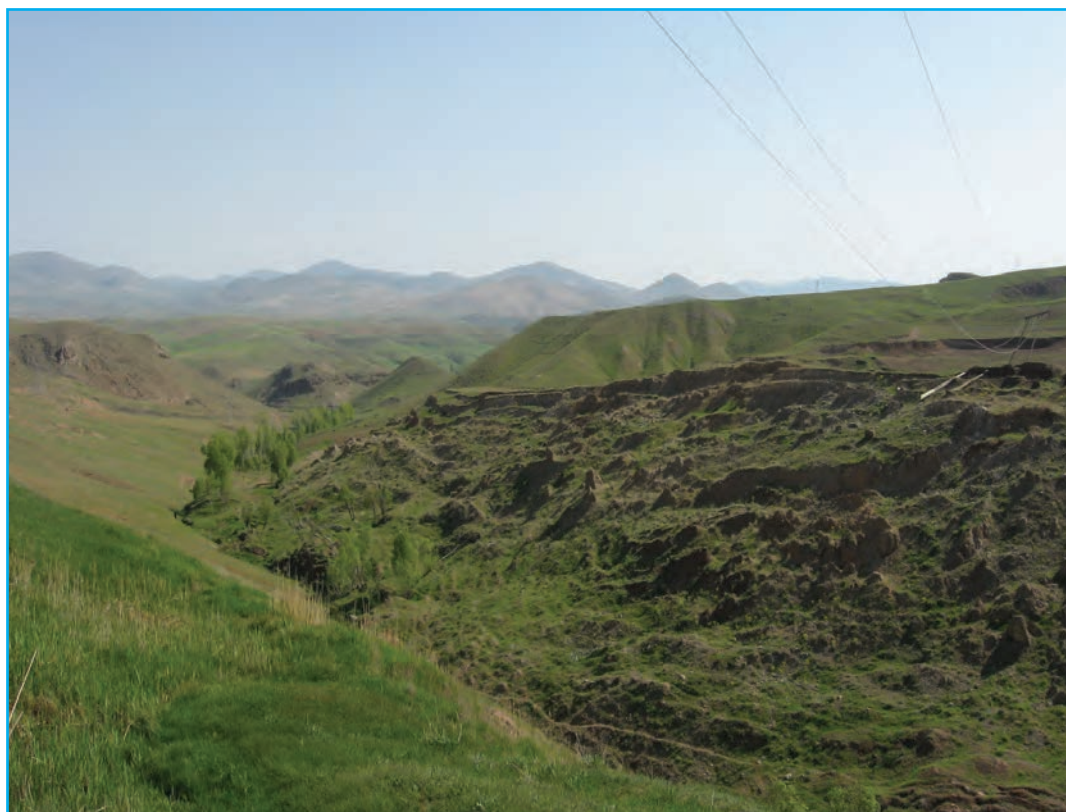
شکل ۱۵-۱- لغزش زمین در نصیرآباد و رزقان
