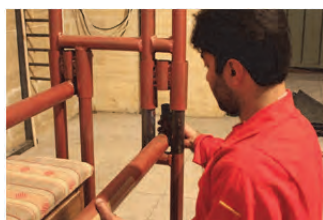
شکل ۱۷- نصب اجزاء دستگاه
