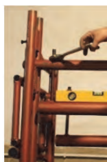
شکل ۱۹ و ۲۰- بستن اجزاء دستگاه با رعایت صحیح فواصل و موازی با افق
