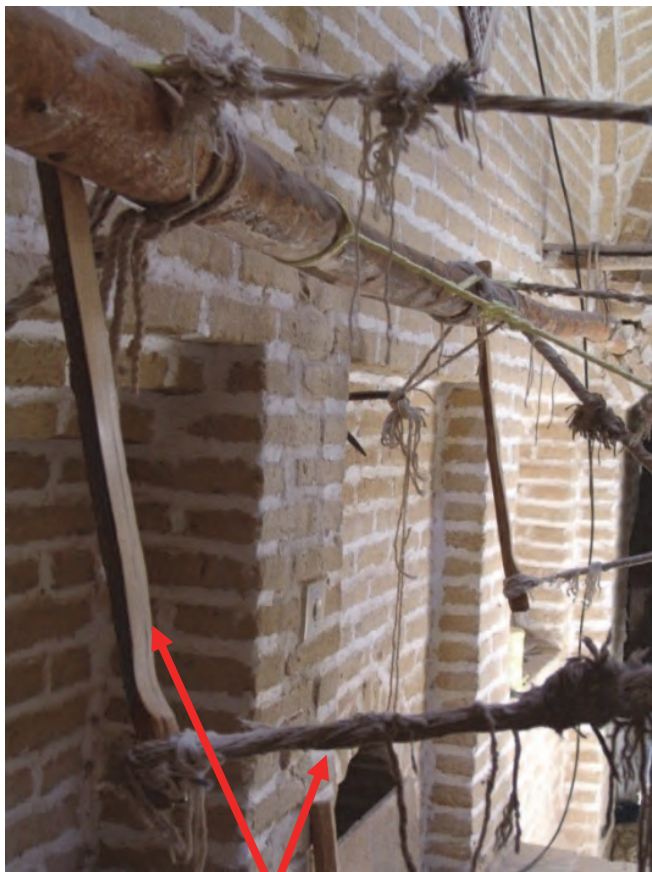
شکل ۳۶- کمونه و نخ اتصال آن
