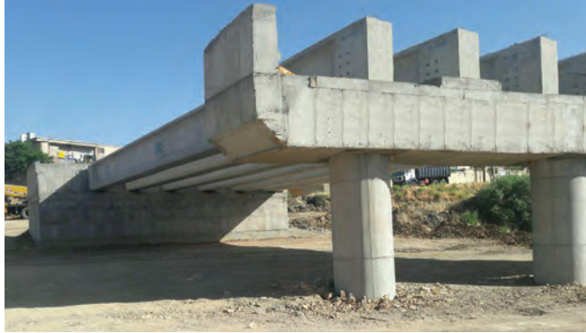
شکل ۱۲- تصویر پل نیمه تمام
