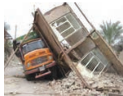
الف) ریزش دیوار در اثر زلزله
