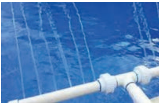
شکل ۱۴- استخر خنک کننده آب پاش
