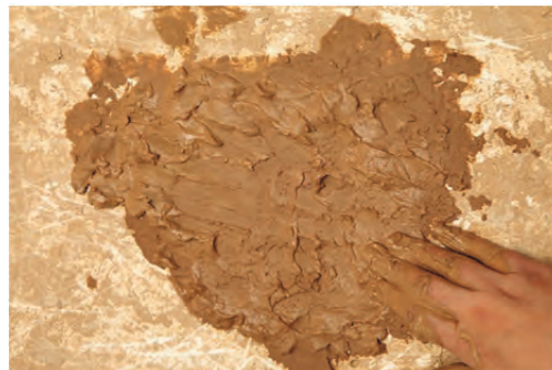
شکل ۱۰- تهیهٔ گل یکنواخت با دوغاب
