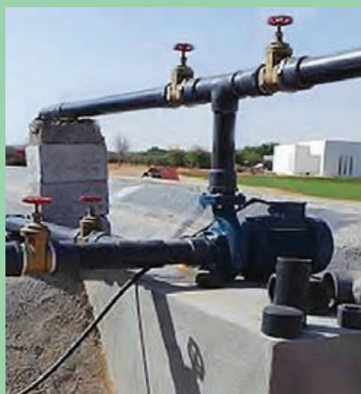
شکل ۱۰- شیر فلکه لوله رانش
