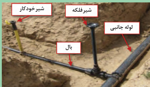
شکل ۱۱- محل شیر فلکه روی بال
