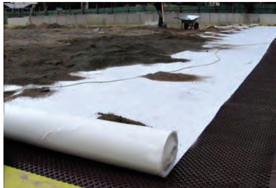
قرارگیری رول ژئوتکستایل در زیر بستر رشد
