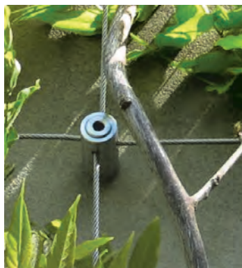
اتصالات به کار رفته در سیستم کابلی و شبکه سیمی
