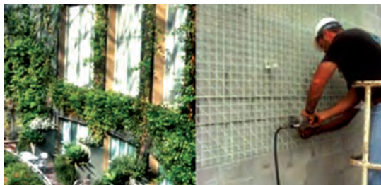
نصب پانل‌ها روی دیوار
