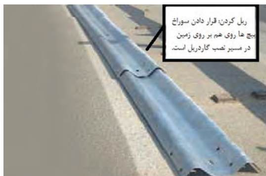
شکل ۴۰- ریل کردن سپری جهت نصب گاردریل (شابلون وجود ندارد)
