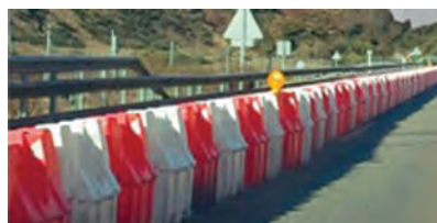
شکل ۲۹- حفاظ پلاستیکی نصب شده در مسیر
