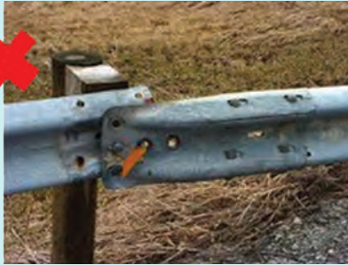
شکل ۱۵- نصب نامناسب گاردریل به دلیل عدم اتصال با پیچ و مهره
