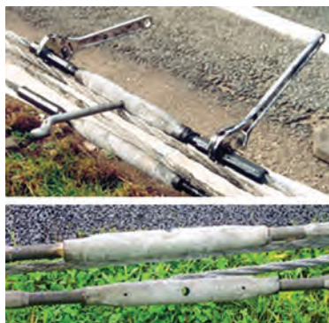
شکل ۴۸ - تنظیم کشش کابل
