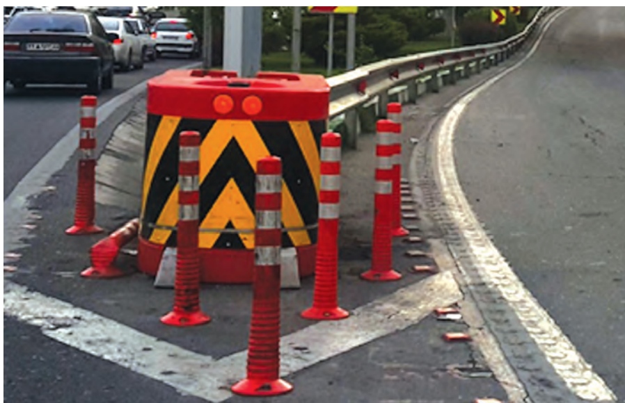
شکل ۲۱ - اجزای ضربه گیر ریلی در تهران
