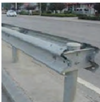
شکل ۱۰- فاصله انداز دوطرفه اجرا شده (ضربه گیر)
