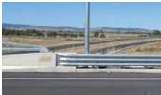
شکل ۸۲ - ناحیه انتقالی حفاظ سه موج به نیوجرسی
