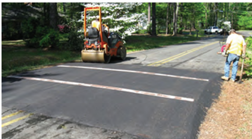
شکل ۲۴- غلتک زدن سطح سرعت‌گاه
