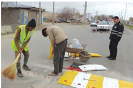
شکل ۱۵- نحوه نصب سرعت گیر پلاستیکی با استفاده از پیچ و مهره
