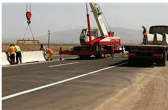
شکل ۵۹- نمونه‌هایی از حمل و نصب نیوجرسی با جرثقیل
