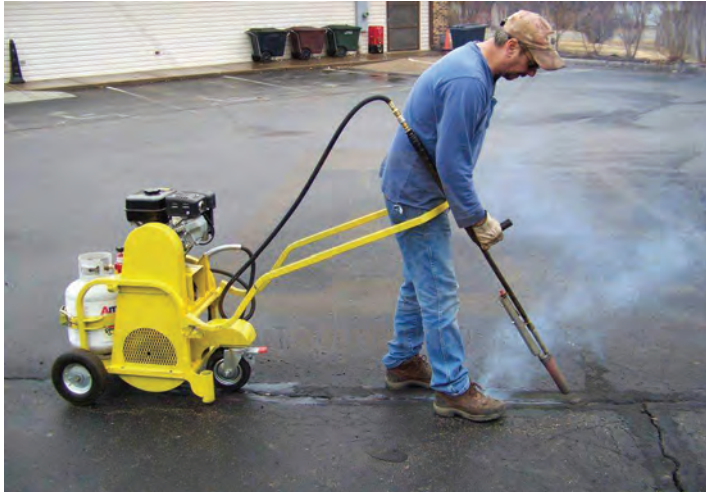
شکل ۲۲- خشک کردن دیواره‌های ترک با دستگاه فشار هوای داغ
