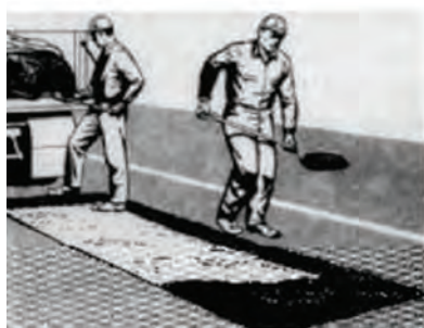
پر کردن محدوده لکه گیری با آسفالت
