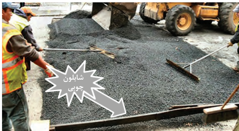
شکل ۲۳- اجرای سرعت‌گاه آسفالتی
