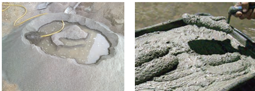
شکل ۱۸- طرز تهیه ملات ماسه سیمان
