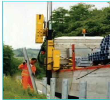
شکل ۳۴- چکش هیدرولیکی گاردریل کوب
