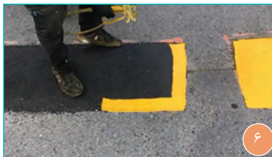
شکل ۷- مراحل اجرای سرعت گیر آسفالتی
