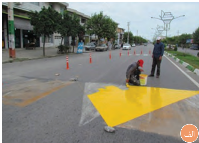
شکل ۲۷- رنگ‌آمیزی سطح روسازی
