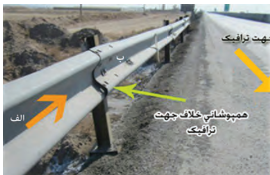
شکل ۴۱- جهت صحیح ریل کردن سپری
