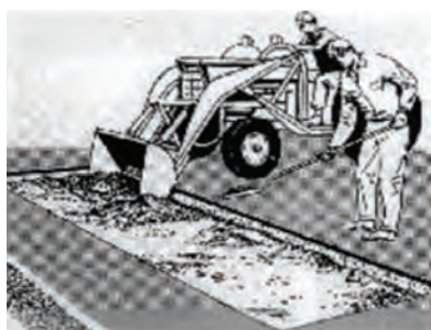
برداشتن لایه های آسفالتی و اساس
