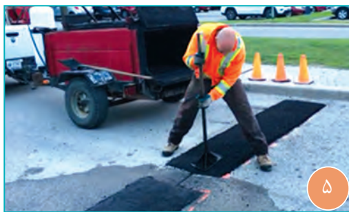
شکل ۷- مراحل اجرای سرعت گیر آسفالتی
