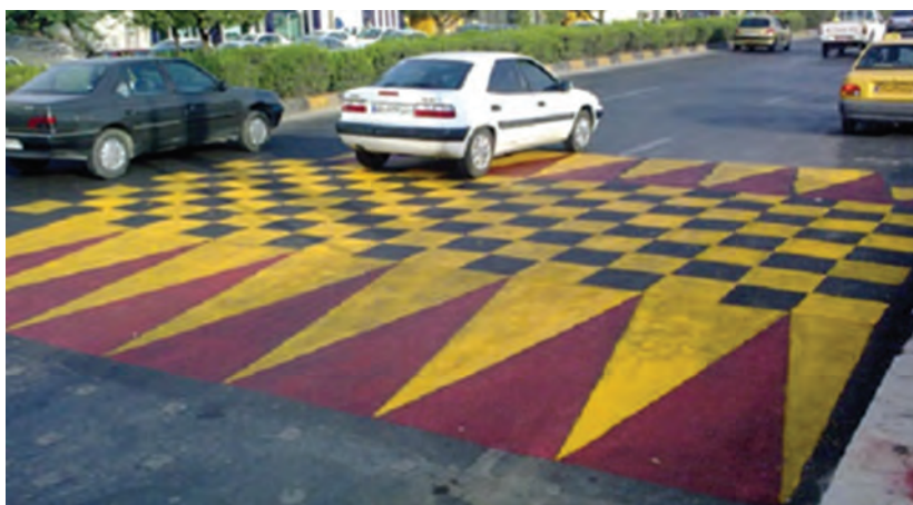
شکل ۲۵- نمونه‌ای از نحوه خط‌کشی سرعت‌کاه
