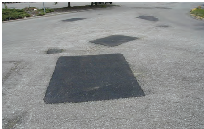
شکل ۹- نمونه‌ای از لکه‌گیری در روسازی آسفالتی
