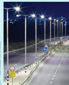
شکل ۷۶- ایمن سازی چراغ برق
