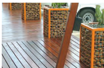
شکل ۷- محوطه‌سازی با اجرای جعبه‌های گابیونی معابر
