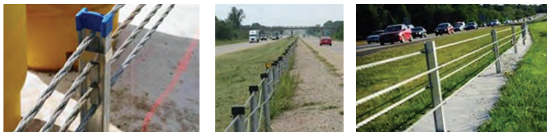
شکل ۴۶- نمونه‌هایی از اتصال کابل به پایه‌ها
