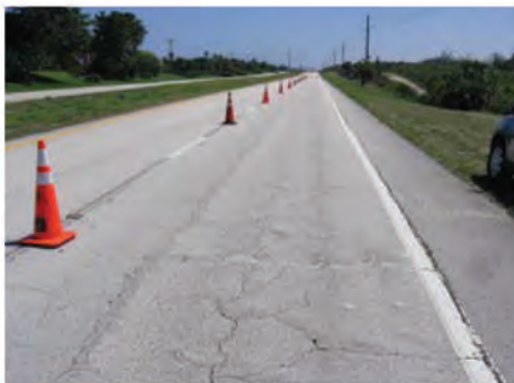
شکل ۳- ترک‌های بلوکی
