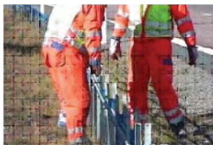
شکل ۶۷- تعمیر حفاظ کابلی
