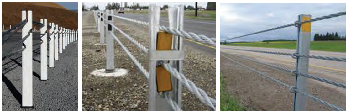
شکل ۱۸- نمونه‌هایی از انواع پایه های حفاظ کابلی
