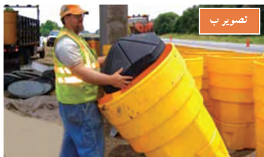
شکل ۲۲- چیدمان بشکه‌ها و قرار دهی مخروط درونی
