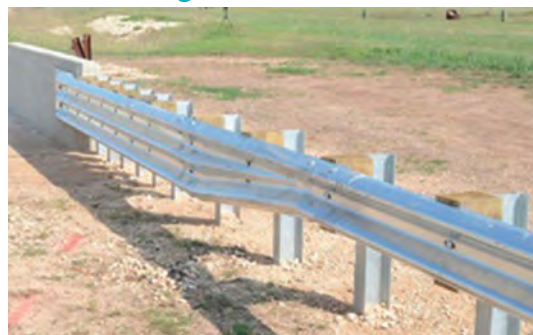
شکل ۸۳ - ناحیه انتقالی حفاظ دو موج به سه موج و حفاظ سه موج به نیوجرسی
