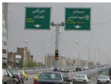
شکل ۲۹ - نمونه‌ای از تابلوهای هدایت مسیر / خروجی (صلیبی)
