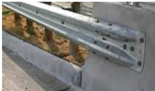
شکل ۸۱ - ناحیه انتقالی حفاظ دو موج به نیوجرسی
