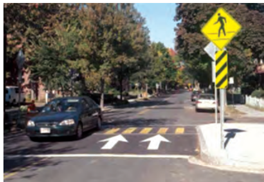
شکل ۲۰- نمونه‌ای از گذرگاه برجسته عابر پیاده
