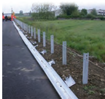
شکل ۴۳- نمونه‌ای از نصب پایه‌های گاردریل با ریسمان‌کشی
