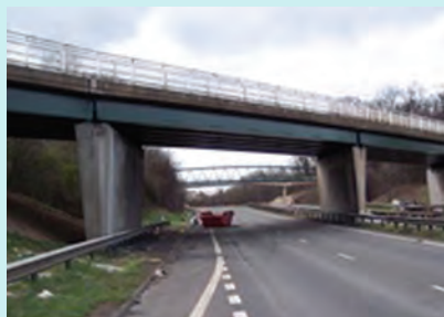
شکل ۷۸- ایمن سازی پایه های پل
