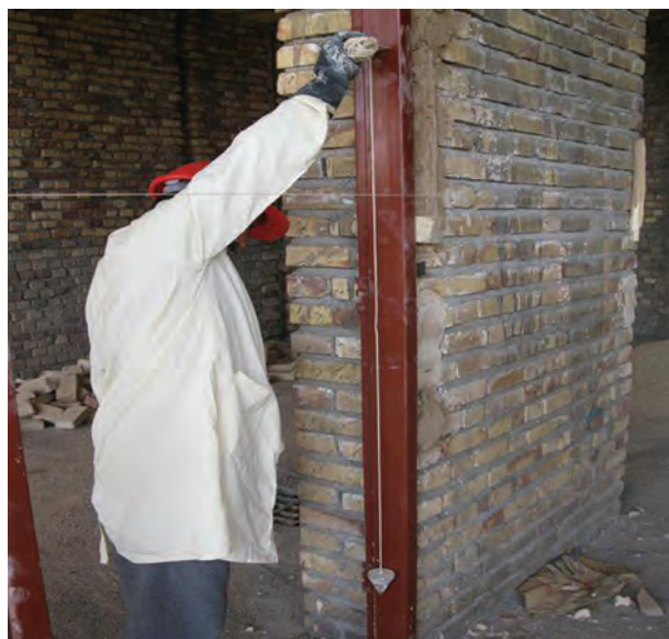
شکل ۳-۲۳: شاقول کردن وادار
