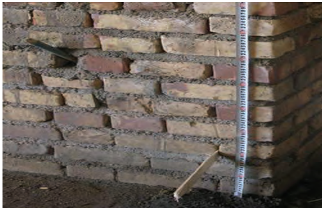
شکل ۳-۳۳: جدا کردن خط تراز روی دیوار
