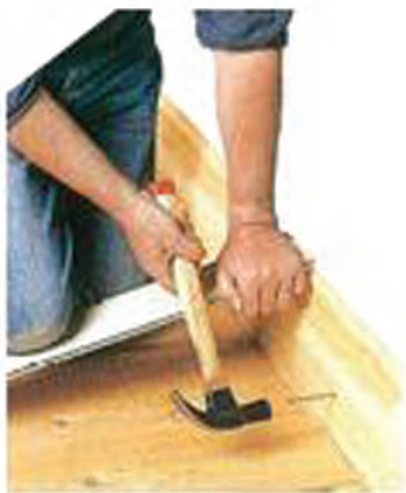
شکل ۳- ۲۹: نصب قرنیز چوبی با میخ
