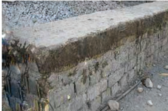
شکل ۱- ۲۹: کرسی چینی یا عایق کاری رطوبتی
