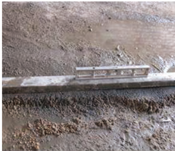
شکل ۱- ۶۹: تراز کردن روی ملات
