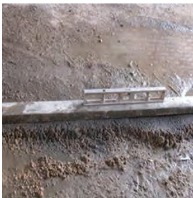
شکل ۱-۱۰۵: تراز کردن روی ملات
