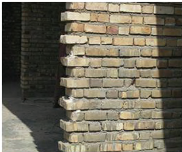
شکل ۱-۵۲: لابند در دیوار آجری
