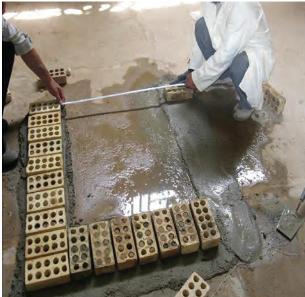
شکل ۱ - ۳۳ (ب): جدا کردن اندازه دو طرف دیگر
