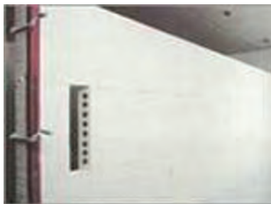
شکل ۱ - ۳۷: دیوار جداکننده با قطعات پیش ساخته گچی
