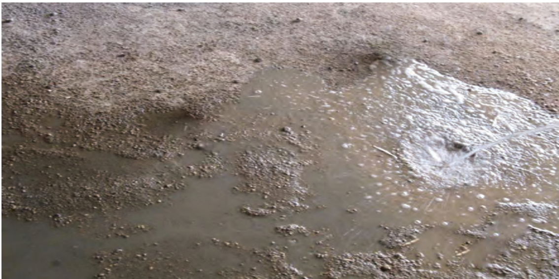
شکل ۱-۶۷: خیس کردن سطح زیر کار
