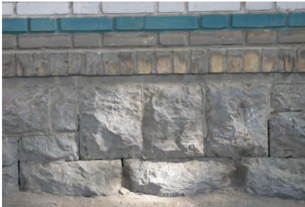
شکل ۱-۱۵ : کاربرد سنگ در پایه‌های ساختمان
