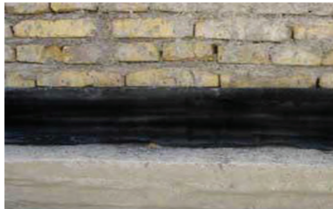
شکل ۱- ۳۰: دیوار روی کرسی چینی
