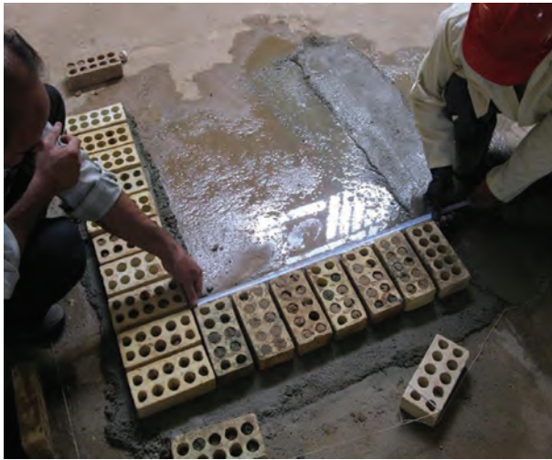
شکل ۱ - ۳۳ (الف): برداشتن طول دیوار
