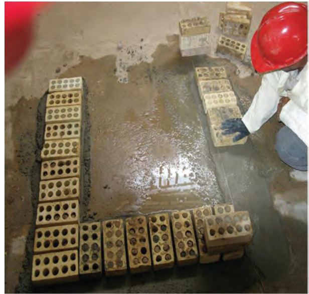
شکل ۱ - ۳۳ (ج): ریسمان کشی و چیدن ضلع سوم
