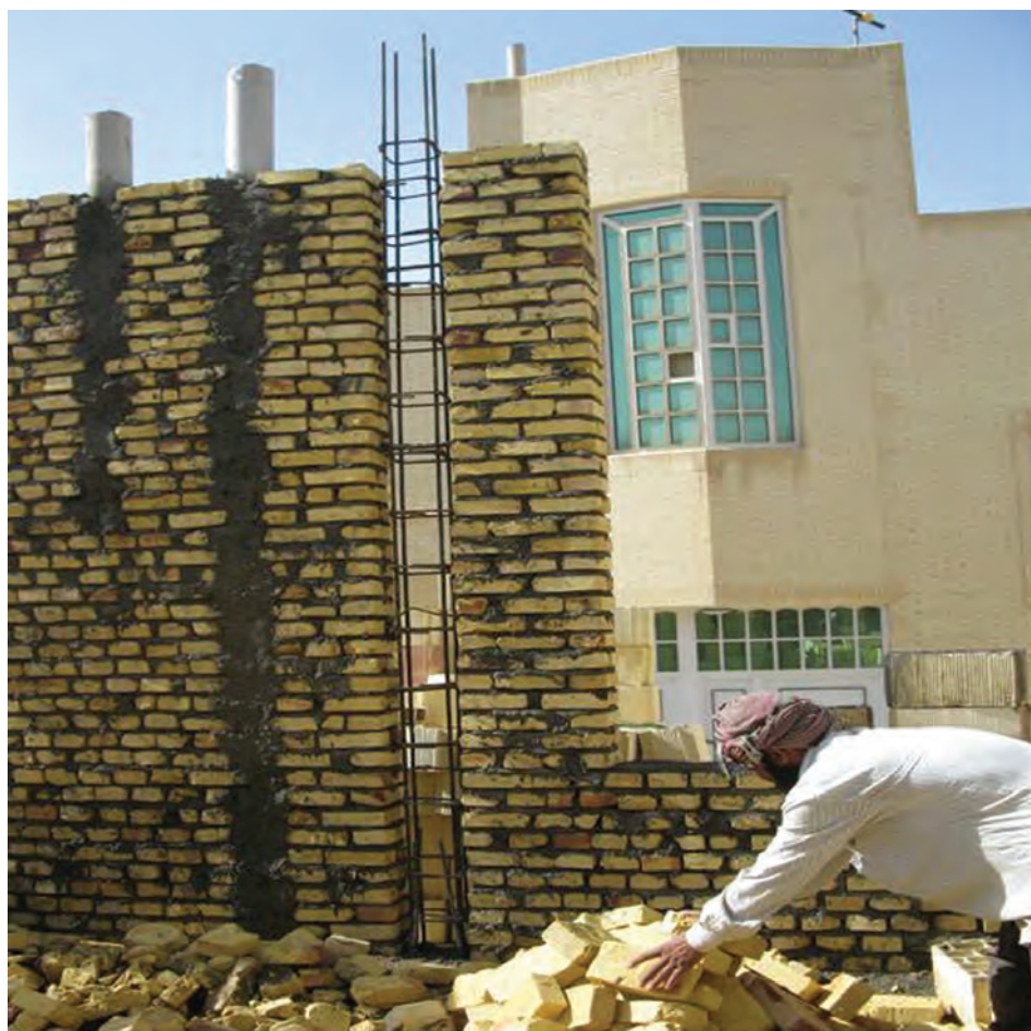
شکل ۱ - ۶۰: اتصال کلاف قائم و افقی در دیوار
