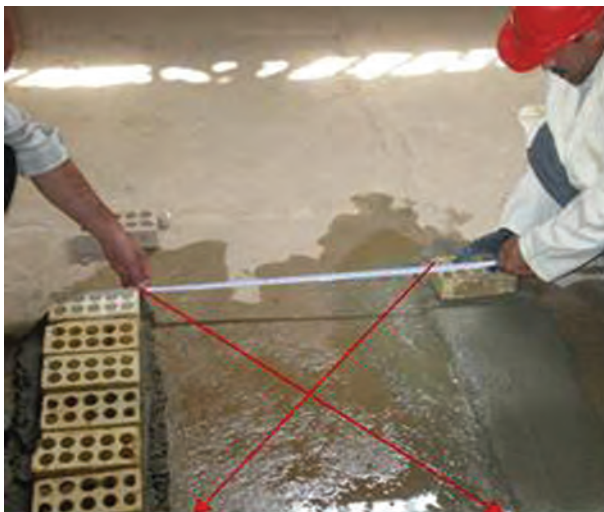
شکل ۱ - ۳۳ (ب): جدا کردن اندازه دو طرف دیگر
