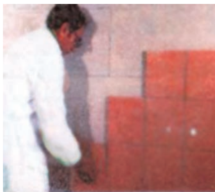
شکل ۱ - ۴۳: نصب کاشی روی قطعات پیش ساخته گچی
