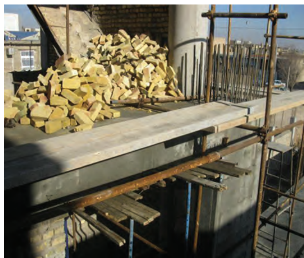
شکل ۱-۲: ضخامت مناسب برای تخته زیر پای
