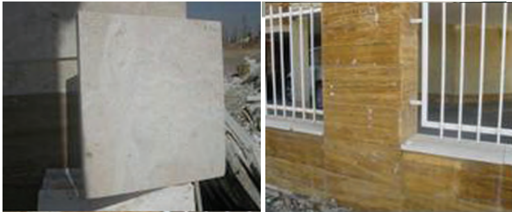
شکل ۱-۱۸: کاربرد سنگ رسوبی در نما
