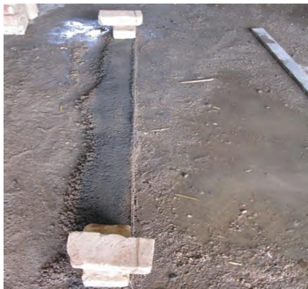
شکل ۱- ۹۰: بادخور نمودن ریسمان کار
