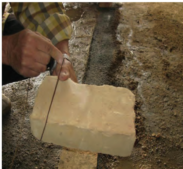
شکل ۱- ۷۲: نحوه بستن ریسمان کار به آجر
