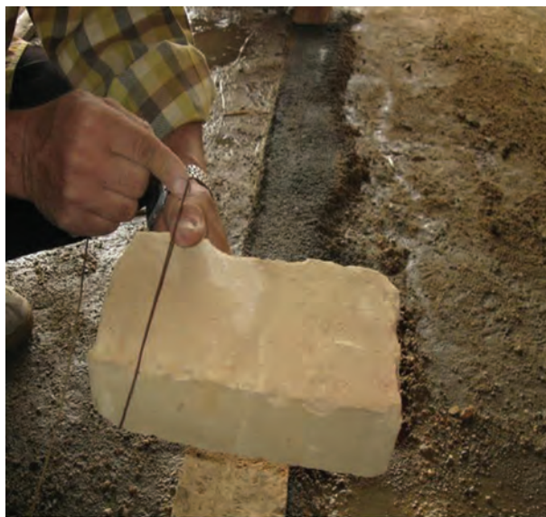
شکل ۱- ۸۹: نحوه بستن ریسمان کار به آجر
