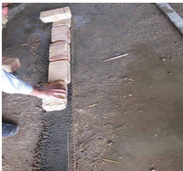
شکل ۱- ۷۴: نحوه چیدن آجر در امتداد ریسمان کار
