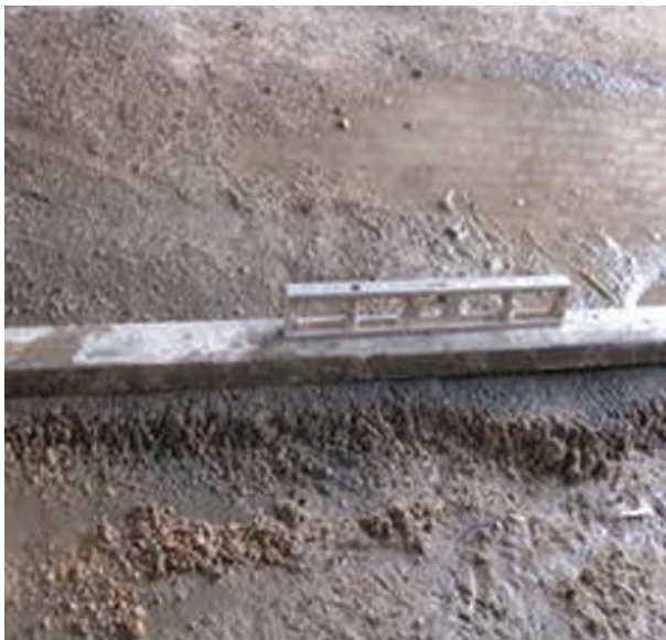
شکل ۱ - ۸۶: کنترل تراز سطح ملات
