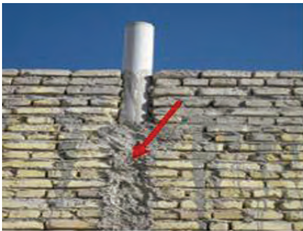
شکل ۱ - ۶۵: پر کردن درز لوله‌ها
