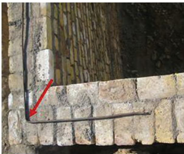
شکل ۱ - ۵۵: میلگرد گذاری در محل اتصال دو دیوار
