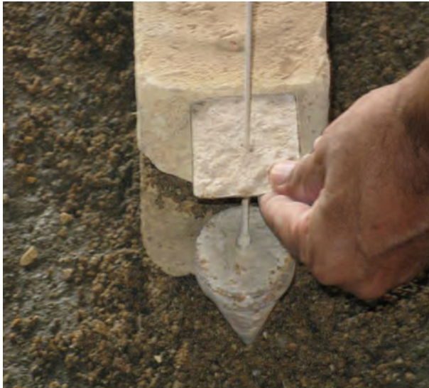
شکل ۱- ۷۷: شاقول کردن نبش کار
