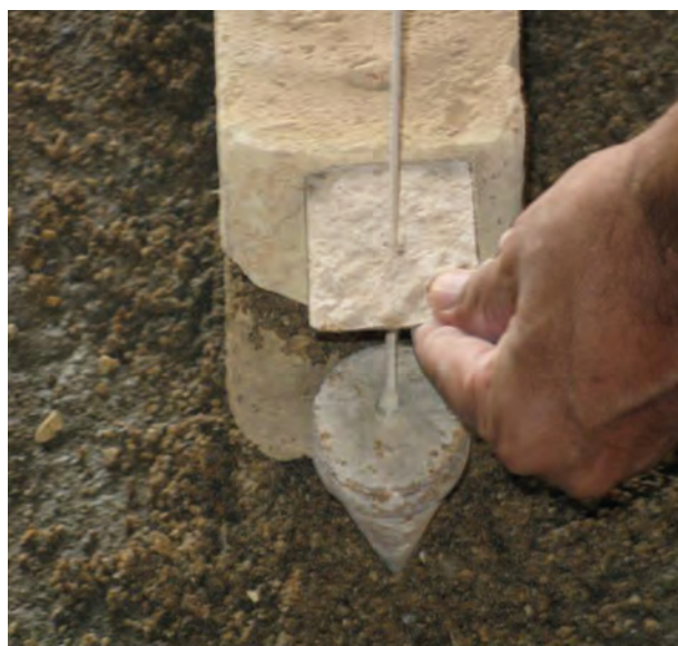
شکل ۱-۹۴: شاقول کردن نبش کار
