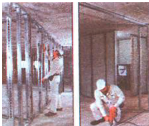
شکل ۱-۴۴: قاب سازی جهت اتصال روکش های گچی
