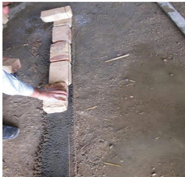
شکل ۱-۹۱: نحوه چیدن آجر در امتداد ریسمان کار
