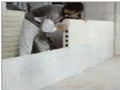
شکل ۱ - ۳۹: جدا کردن فضا با قطعات پیش ساخته گچی
