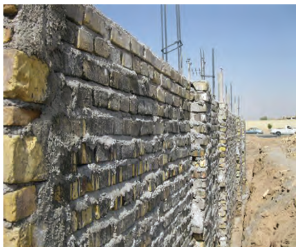
شکل ۱- ۲۶: دیوار آجری با کلاف بندی قائم
