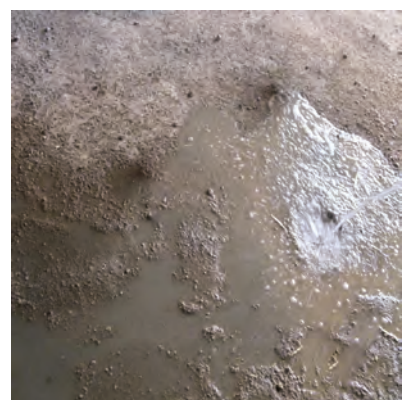
شکل ۱-۱۰۳: خیس کردن سطح زیر کار
