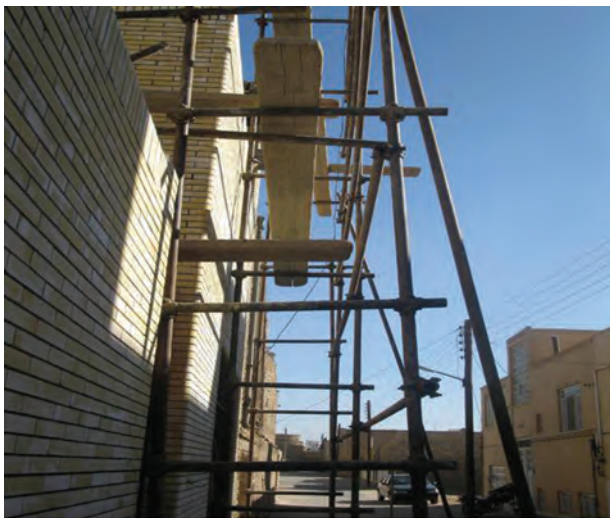
شکل ۱-۱: داربست فلزی برای چیدن دیوار
