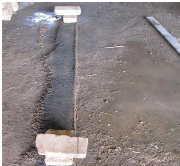
شکل ۱- ۷۳: بادخور نمودن ریسمان کار
