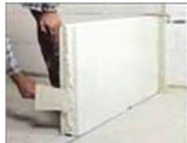
شکل ۱ - ۳۶: طریقه نصب بلوک های گچی
