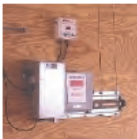
شکل ۳-۲۳- کنترل خودکار هواکش‌ها
