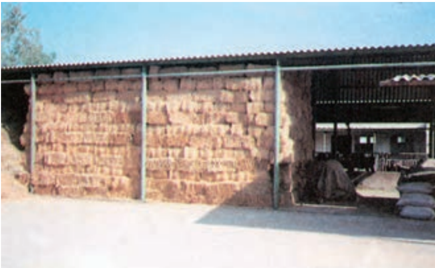
شکل ۱۰-۲- نحوه‌ی نگهداری بسته‌ها در فضای سرپوشیده
