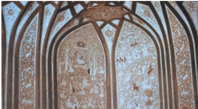
تصویر ۳۱- بخشی از یک ساختمان قدیمی در نایین - نیمه دوم قرن دهم هجری (صفویه)
